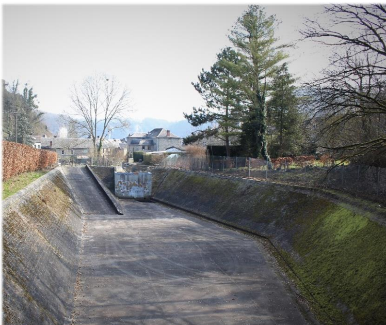
Bassin d'orage rue du Val
