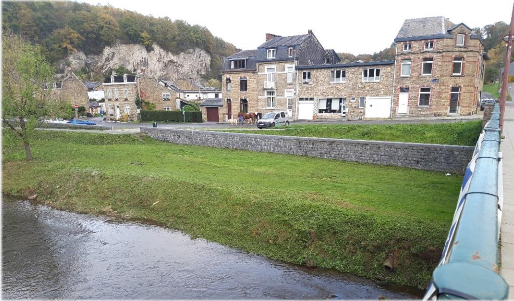
Mur anti-crue Quai de la Cité
